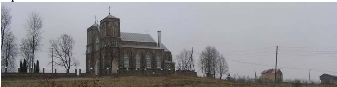
2.2.1. attēls. Jezupovas Sv.Pētera un Pāvila Romas katoļu baznīca. Foto © L.Hrisanfova
