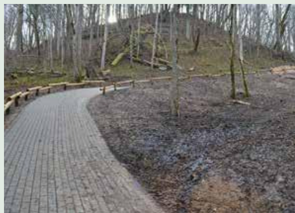
15.15. att. Noteikti jāizvairās no plašu un pamatīgu celiņu būvniecības uz nogāzēm, jo tiek neatgriezeniski iznīcināta daļa biotopa un veicināta erozija. Foto: S. Ikauniece.
