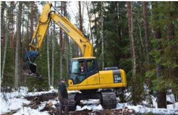
17.10. att. Grāvja aizbēršana ar ekskavatoru Gaujas Nacionālajā parkā. Foto: S. Ikauniece.
