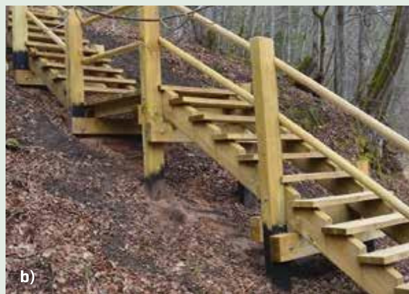
15.12. att. Kāpnes nogāzē (A), paceltas virs zemes uz ieraktiem koka stabiem (B). Foto: S. Ikauniece.
