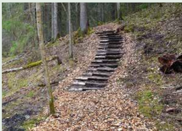
15.14. att. Nelielā slīpumā izveidotas kāpnes no koka šķīlām, celiņam un kāpņu apkārtnē izmantota koksnes šķelda. Foto: S. Ikauniece.
