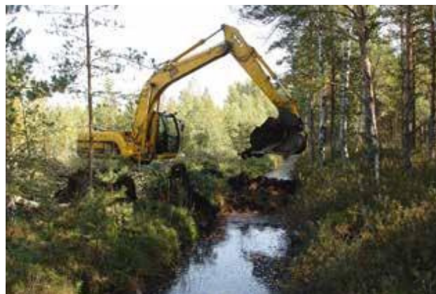
17.6. att. Kūdras aizsprosta veidošana ar ekskavatoru Lielā Ķemeru tīreļa malā. Foto: J. Ķuze.
