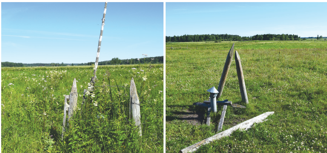
7.4.7. att. Gruntsūdens līmeņa mērīšanas akas un virsūdens līmeņa mērīšanas latas katru gadu jāapseko un jāatjauno, īpaši teritorijās, kur notiek pali vai ganās dzīvnieki. Dvietes palienē 2012. gadā uzstādīto aku un latas stāvoklis 2015. gadā.
