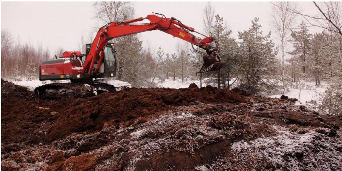
23. attēls: Kūdras aizsprosta būve dabas liegumā "Melnā ezera purvs" 2012. gadā. Foto: M. Pakalne
