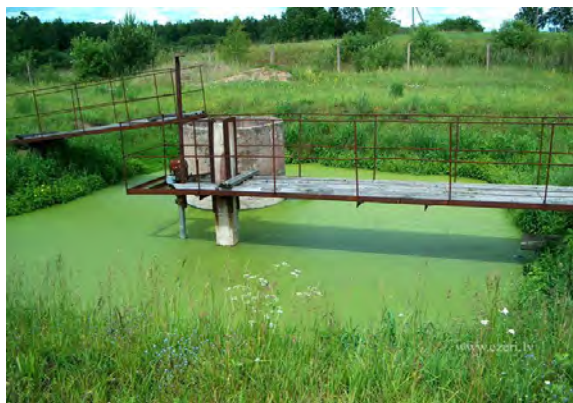
13.attēls. Lielaucē notekūdeņu attīrīšanas iekārtu nosēddiķis.
