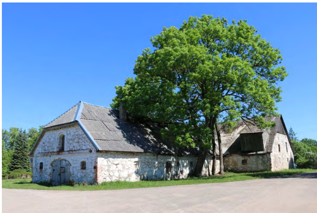
5.5. attēls. Skats uz bijušās Lēnu muižas saimniecības ēkā – kūti, kas celta 1845. g.; tradicionālais dakstiņu jumts padomju periodā nomainīts ar šiferi, uz ēkas dienvidaustrumu spārna jumta izbūvēts arhitektoniski neiederīgs izvirzījums (Foto: J. Soms)
