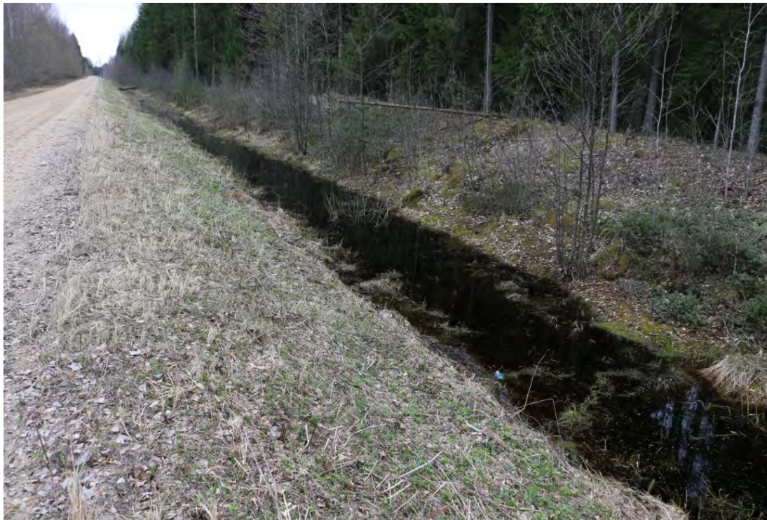
4.1.2. attēls. Atjaunotās meliorācijas sistēmas grāvis uz DL teritorijas austrumu robežas (J. Soma foto)
