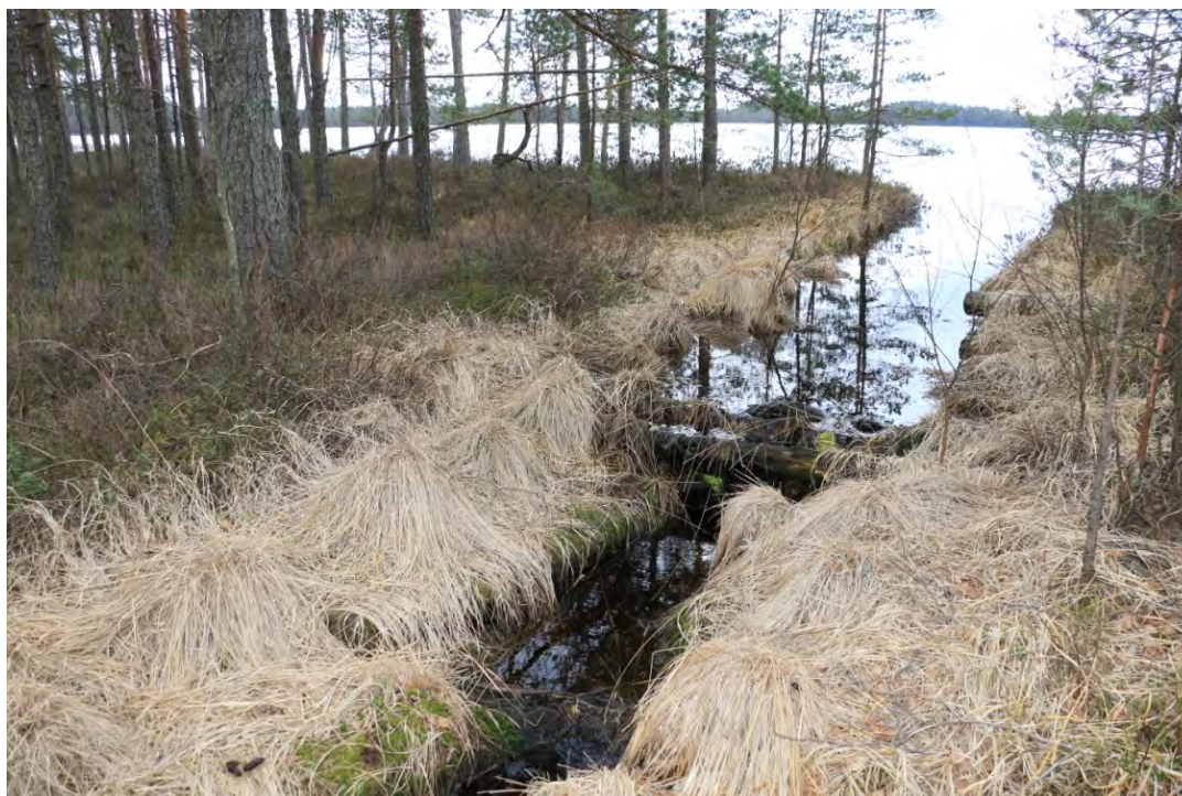
2.4.6. attēls. No baļķiem izveidots aizsprosts uz grāvja, kas novada ūdeņus no Sūpes ezera uz Klauci. Aizsprosta ietekmē Sūpes ezerā līmenis paaugstināts par 0,4 m (fotografēts 11.04.2019., J. Soma foto)
