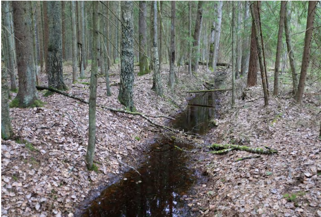
4.1.3. attēls. Piesērējis meliorācijas sistēmas grāvis, kurā novērojama ūdens plūsma; DL teritorijas DA daļa (J. Soma foto)
