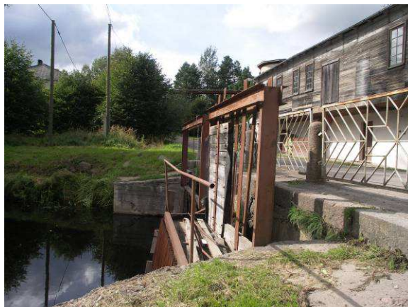
15. attēls. Gravass HES.
