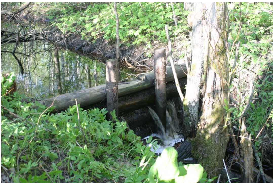
17. attēls. Ūdens noplūde starp aizsprosta baļķiem.
