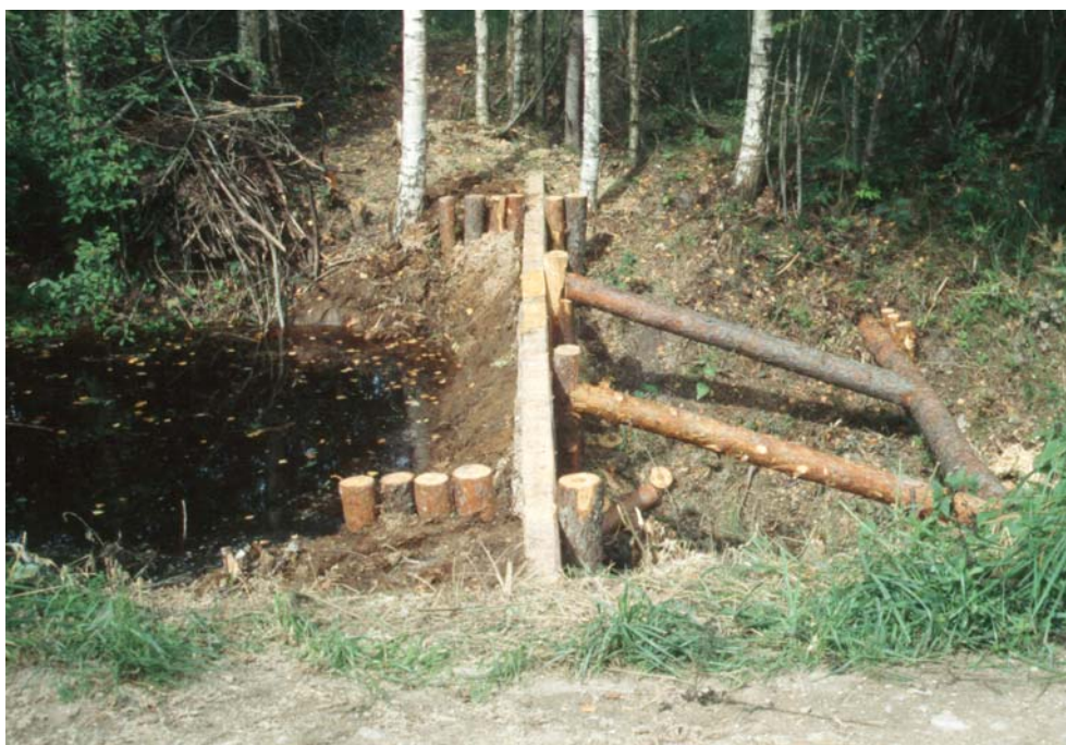
10. attēls. No 10x10 cm koka brusām izgatavots aizsprosts ar slīpu sablīvētu kūdras slāni aizsprosta augšpusē un ar diviem hidroizolācijas nodalījumiem aizsprosta galos (2000. gada foto, pie aizsprosta 15/14-A).
