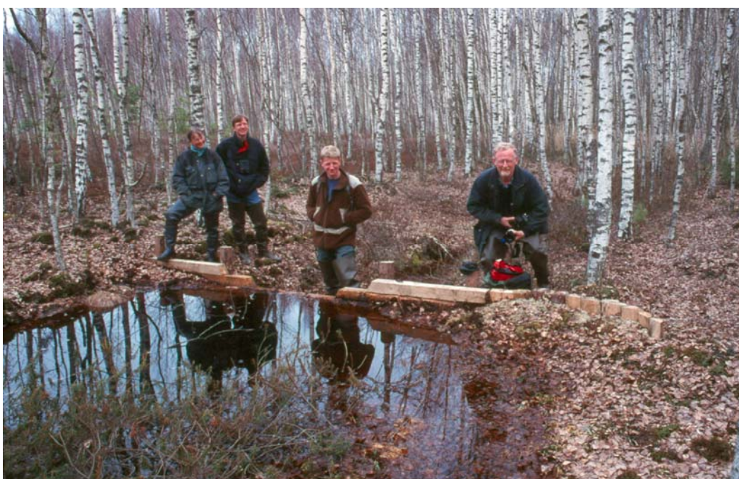
11. attēls. No 10x10 cm koka brusām izgatavots aizsprosts ar papildus barjeru no vertikāli iedzītiem pāļiem ūdens apkārt noplūdes novēršanai (2000. gada foto, pie aizsprosta 3/4-B).
