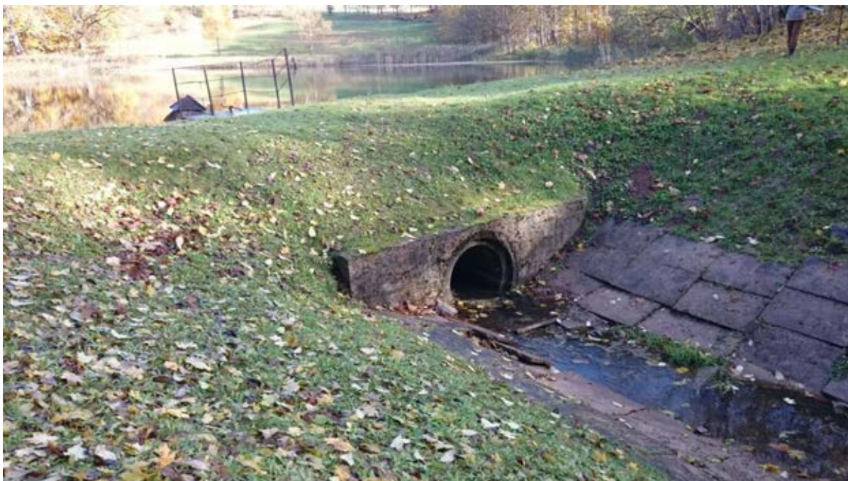
3.foto. Ūdens līmeņu regulēšanas būves izplūde, skats no lejasbjefa
