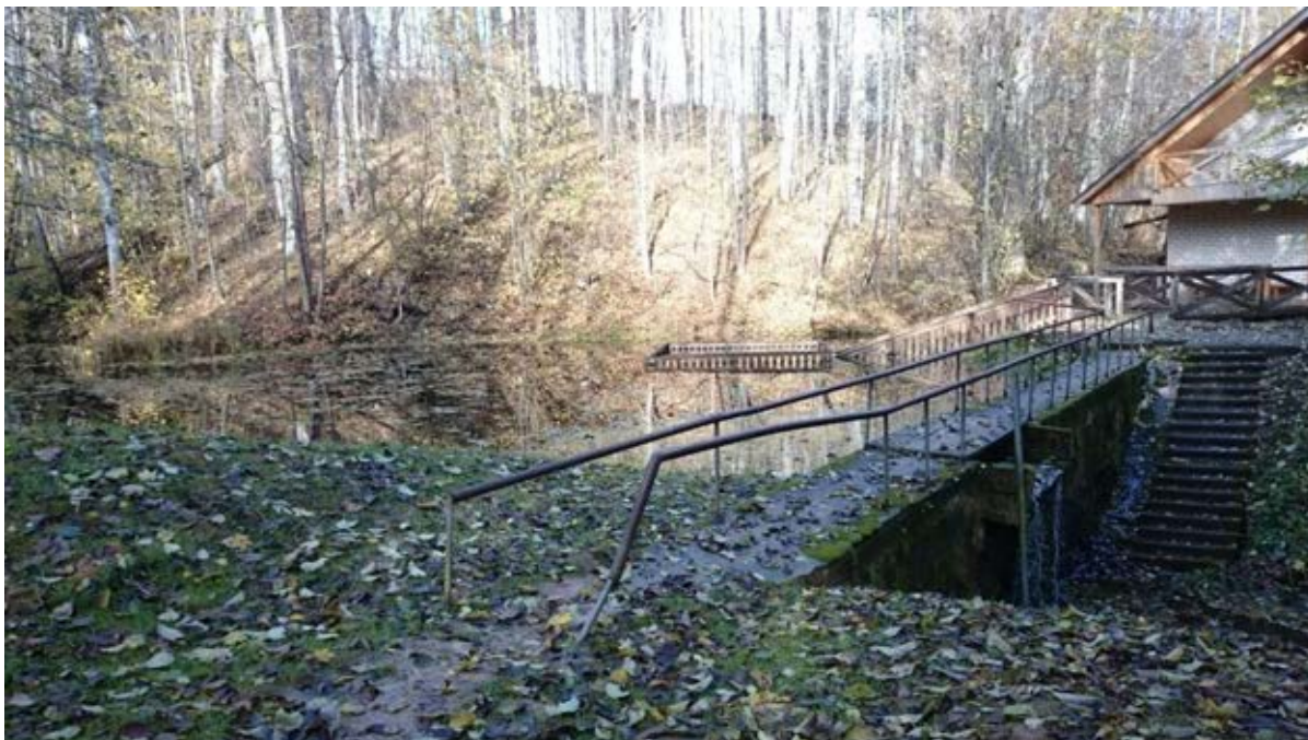
1.foto. Dīķa un ūdens līmeņu regulēšanas būves kopskats, skats no labā krasta
