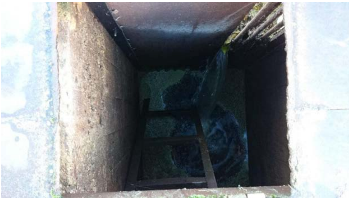
5.foto. Regulēšanas būves dzelzsbetona torņa iekšpuse, skats no augšas
