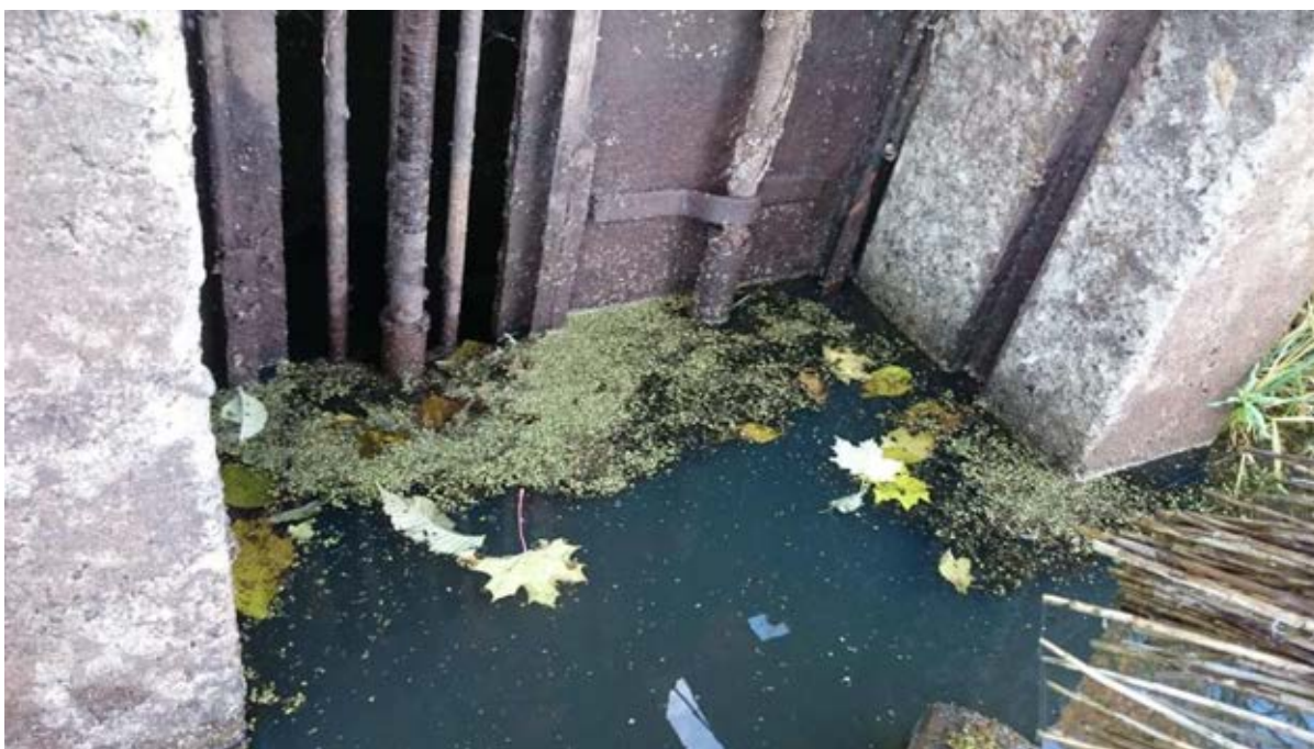
4.foto. Mazūdens perioda un vidējā caurplūduma novadīšanas augšējā atvere, skats no augšbjefa
