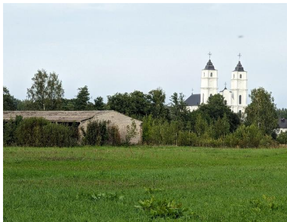
4.2.6. attēls. Skats uz Aglonas baziliku no autoceļa V762, kur priekšplānā kādreizējo mehānisko darbnīcu ēka, kas jau iepriekšējā DA plānā tika norādīta kā vidi degradējoša un nojauicama. Foto: K. Vilciņa.
