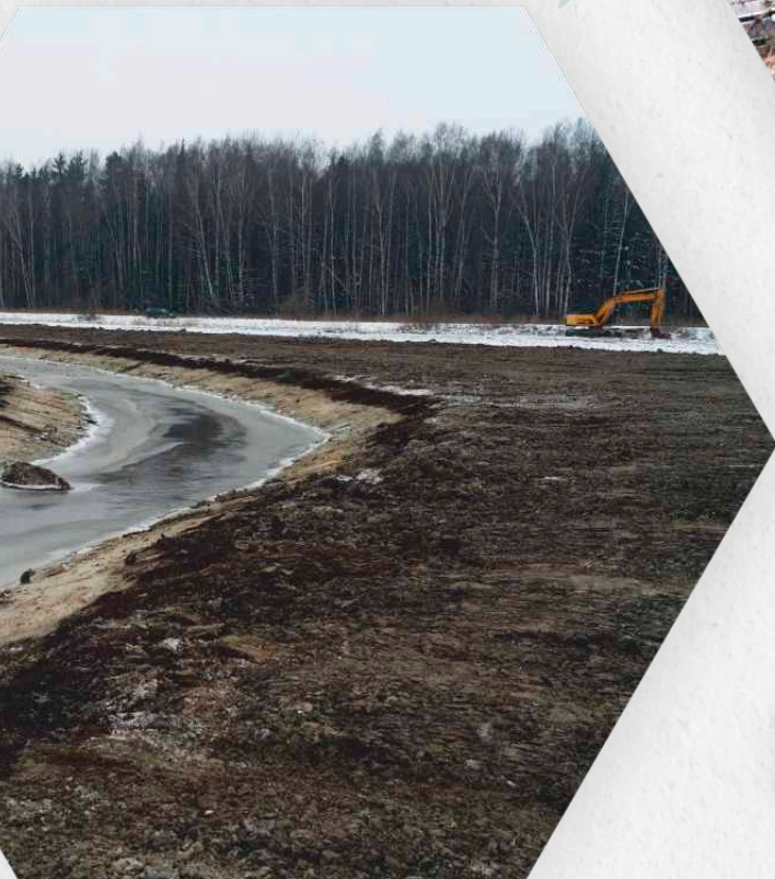
Grunts izlīdzināšana Skudrupītes krastos. Ground levelling on the banks of Skudrupīte River.
