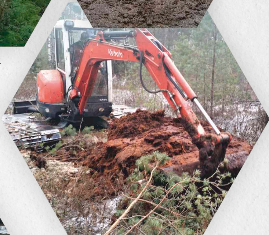
Grāvja aizsprosta veidošana Zaļajā purvā. Construction of ditch dam in Green bog.
