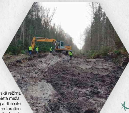
Grāvja aizsprosta veidošana Zaļajā purvā. Construction of ditch dam in Green bog.
