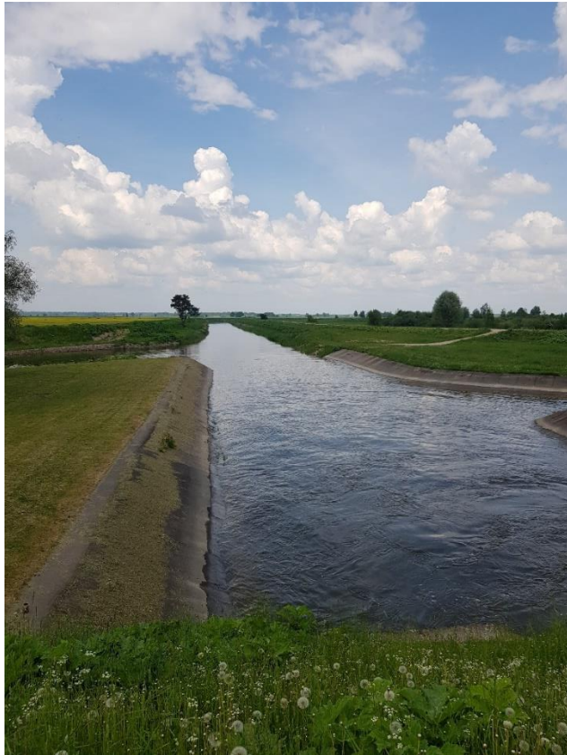
24.attēls. Skats uz Meirānu kanālu 56.734167, 26.725556.
