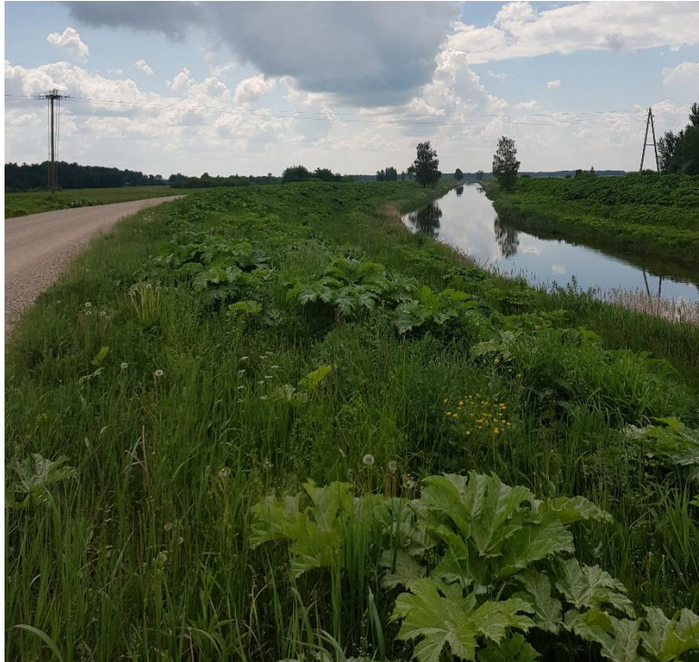
22.attēls. Skats uz Meirānu kanālu 56.757475, 26.713222.
