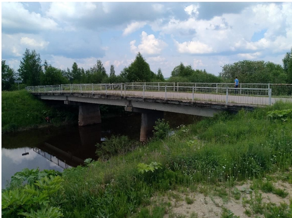
23.attēls. Skats uz Meirānu kanālu 56.757431, 26.713575.
