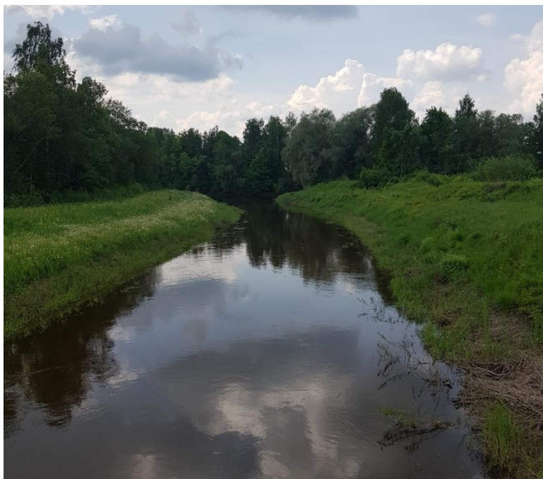
21.attēls. Skats uz Meirānu kanālu.
