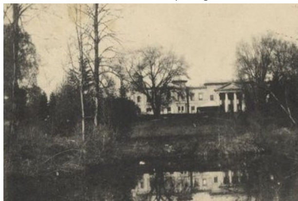
9.Attēls.Skats uz muižas ēku no dīķa puses
