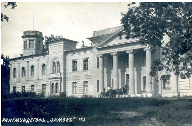
4.Attēls.Rembates muižas ēka pirms 1914.gada
