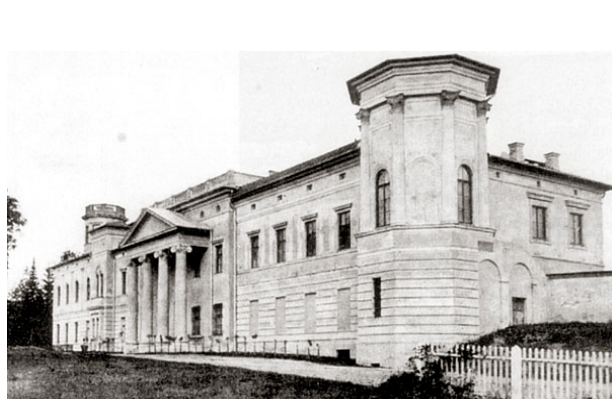
11.Attēls. Rembates muižas ēka 20.gs.sāk.
