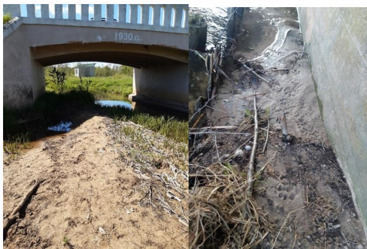
2. att. Ūdru pazīmju sastopamība zem tiltiem bez balstiem un atklātām krastu nogāzēm. Foto: A.Ornicāns.
