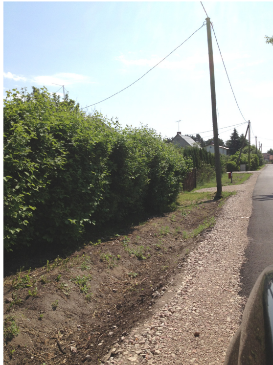
Foto Nr.11 Grāvis bez noteces un bez susinošā efekta rekonstruētajā Stadionā ielā
