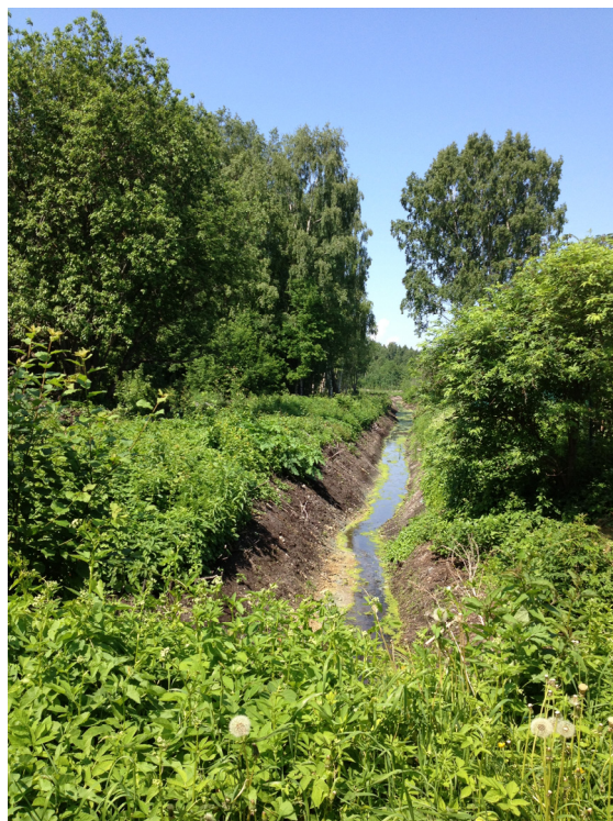
Foto Nr.12 Rekonstruēts grāvis Meža ielas galā
