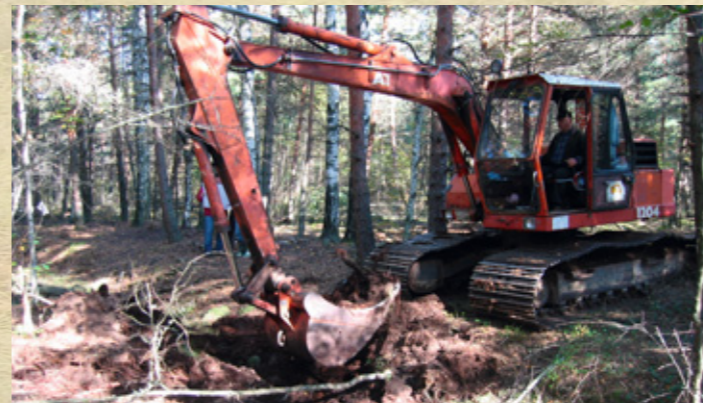
Foto: V. Baroniņa Kūdras aizsprostu būve uz nosusināšanas grāvjiem purva malā.
