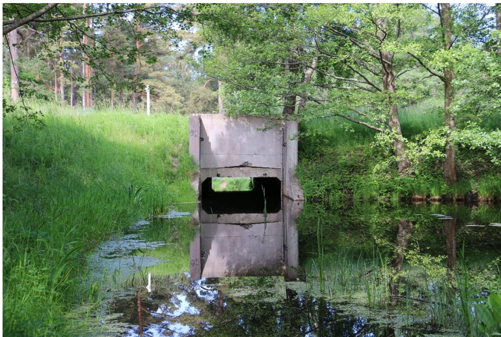
2.3.2. attēls. Cietokšņa kanāla caurteka zem Lībiešu ielas ar demontēto ūdens līmeņa regulējošā aizsprostu ( X_{LKS-92TM} = 275574 un Y_{LKS-92TM} = 317481 ) (Foto: J. Soms)
