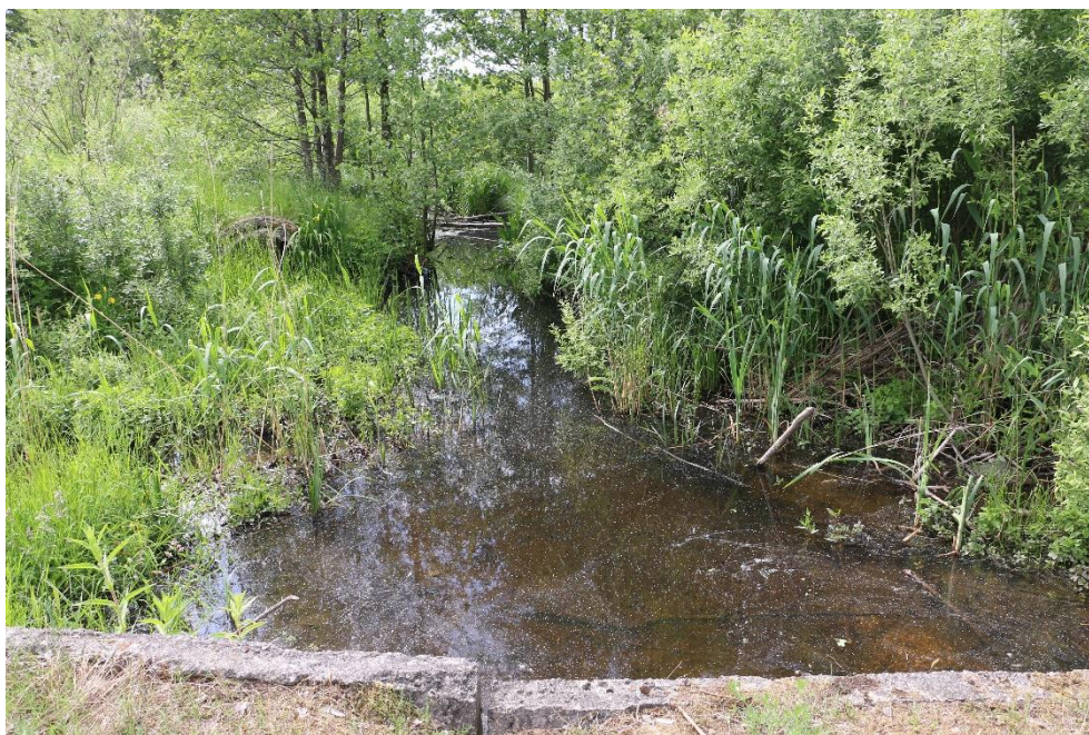
2.3.16. attēls. Piesērējis un daļēji aizaudzis meliorācijas sistēmas grāvis 3422231:3 Dabas lieguma D daļā. Mazūdens periodā notece ekstensīva ( X_{LKS-92TM} = 272076 un Y_{LKS-92TM} = 320614 ) (Foto: J. Soms)
