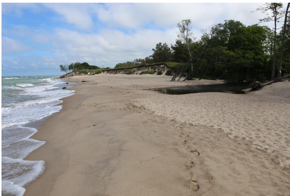
2.3.5. attēls. Cietokšņa kanāla ietekas vieta Baltijas jūrā. Apsekošanas laikā kanāla grīva ir aizpildīta ar smiltīm, noteces uz Baltijas jūru nav ( X_{LKS-92TM} = 276103 un Y_{LKS-92TM} = 316782 ) (Foto: J. Soms)
