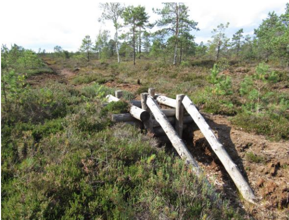
8a. attēls. Viens no diviem koka un kūdras aizsprostiem uz grāvja pa licences laukuma robežu 2019. gada septembra sākumā. Aizsprosts būvēts no baļķiem, pildīts ar kūdru, kā arī augšpus aizsprosta grāvis aizpildīts ar kūdru. Foto austrumu-rietumu virzienā.
