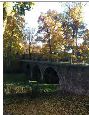
9. attēls. Akmens tilts.
