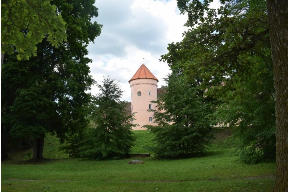
25.att. Skats uz pils apaļo torni. 2021. gada 4. augusts.
