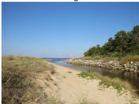
14.9. attēls. Labā krasta nostiprinājums apmēram 0,068 km garumā.
