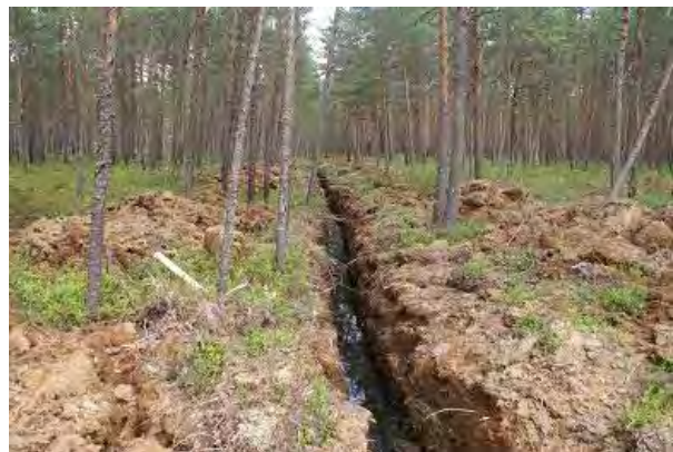
Teritorijas ZR malā 523. kv. izrakts grāvis gāzes vada remontdarbu vajadzībām.
