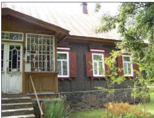
4.1. attēls. Sventes katoļu baznīcas plebānija. Ap logiem grieztas aplodas, slēģi. Foto: I.Virse
