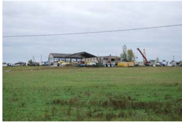
6.4. attēls. Ainavu vizuālo vērtību pazeminošs objekts blakus autoceļam A14
