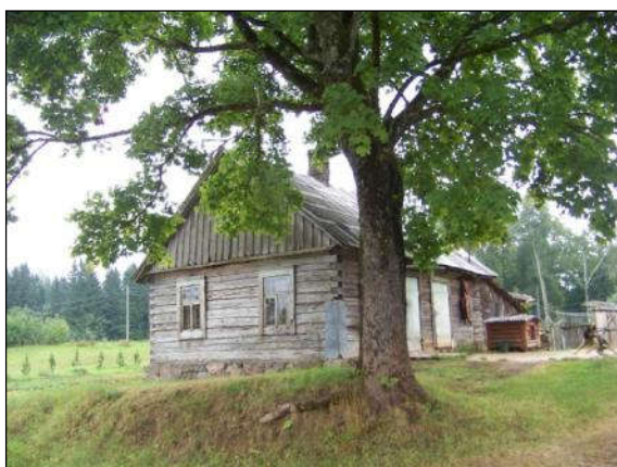
4.5. attēls. Senāka dzīvojamā māja, kas pārveidota par saimniecības ēku. Celta no pietēstiem baļķiem, veidoti gludi pakši, zem zelmiņa uzjumtenis. Grendze. Foto: I.Virse
