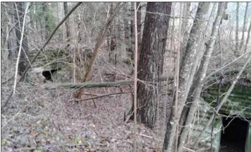
Divas dzelzsbetona blindāžas pie Grendzes upītes. Foto: I. Virse
