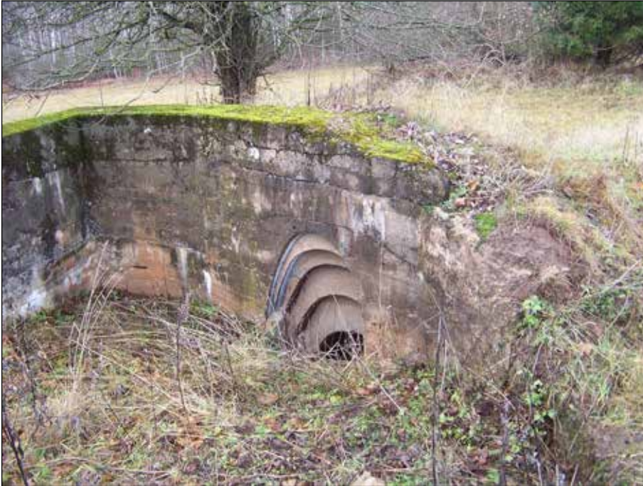
Nocietinājumu sistēma uz ZA no Arodnieku mājām, vidējā būve, atvere uz pazemes telpu. Foto: I. Virse.
