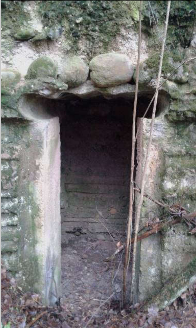
Dzelzsbetona munīcijas noliktavas (?) durvju vieta. Foto: I. Virse
