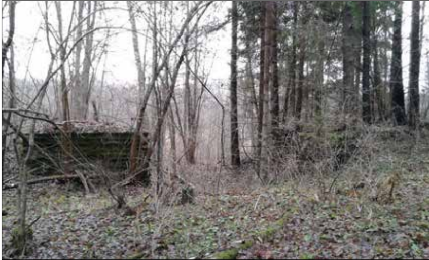
Dzelzsbetona blindāžas un munīcijas noliktavas (?) pie Grendzes upītes, skats no Z. Foto: I. Virse
