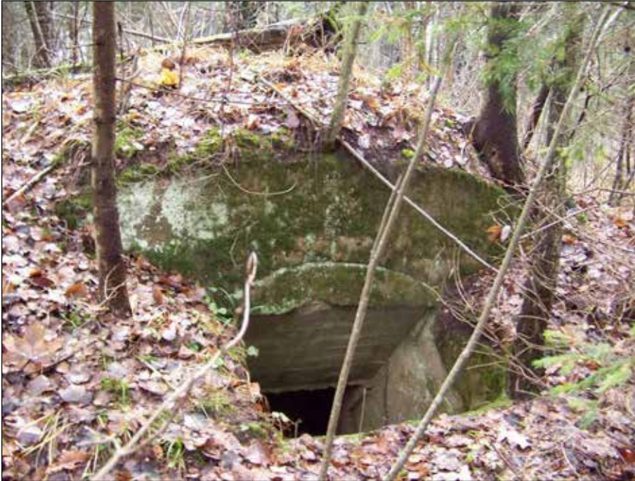
Dzelzsbetona bunkurs pie Kščevas – Birulišķu ceļa, atvere R galā, skats no A. Foto: I.Virse
