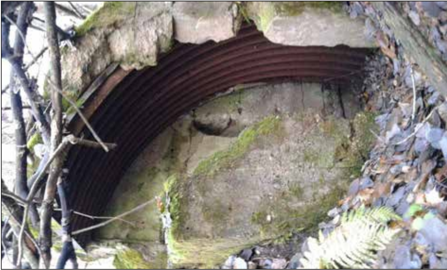
Dzelzsbetona blindāža ar dzelzs arkveida pārsegumu pie Ķieģeļnīcas kapiem. Foto: I. Virse.
