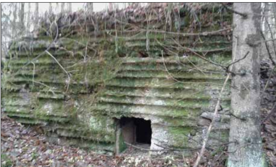
Dzelzsbetona blindāža pie Grendzes upītes. Foto: I. Virse
