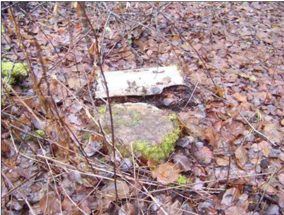
Dzelzsbetona nocietinājumu sistēma pie ceļa Kščeva – Birulišķi, viens no betona pāļiem ceļa R pusē. Foto: I. Virse.
