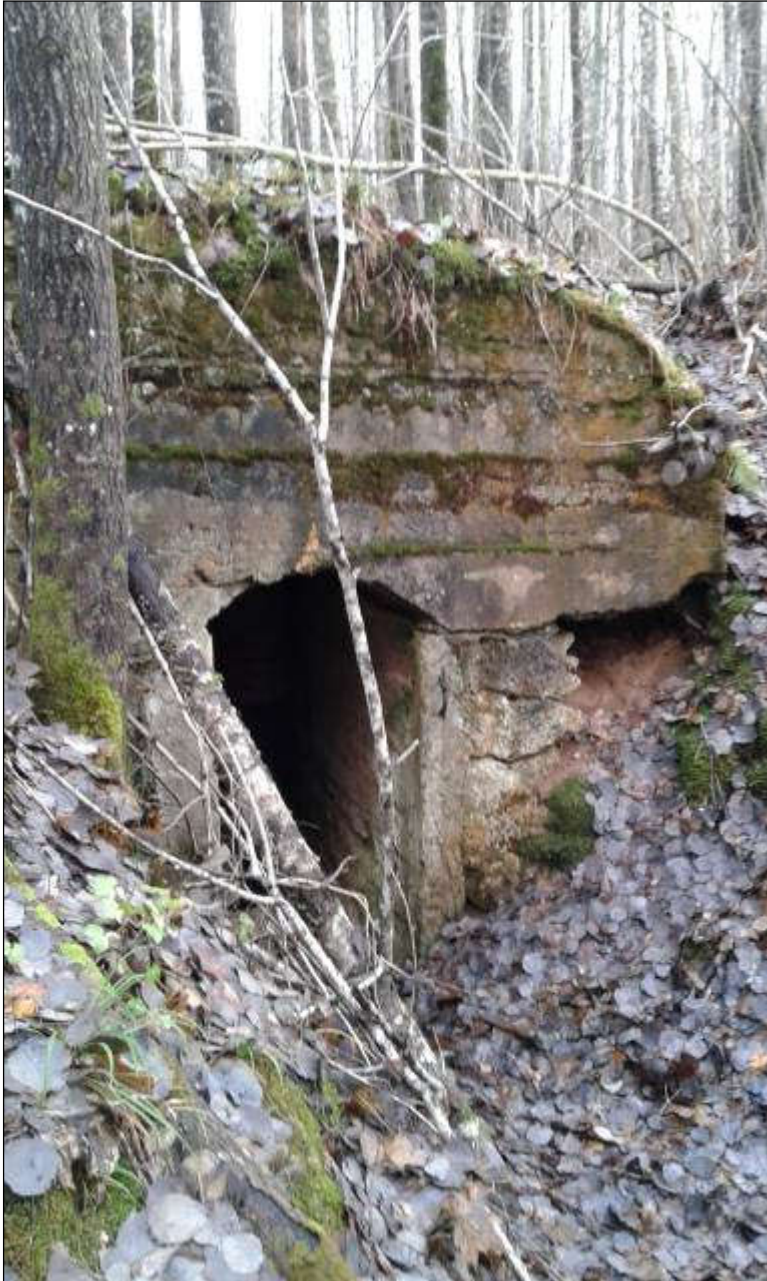
Dzelzsbetona blindāža pie Ķieģeļnīcas kapiem, ieejas vieta. Foto: I. Virse.
