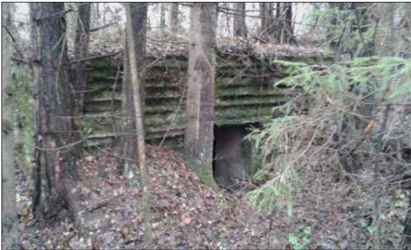
Dzelzsbetona blindāža pie Grendzes upītes, skats no R. Foto: I. Virse
