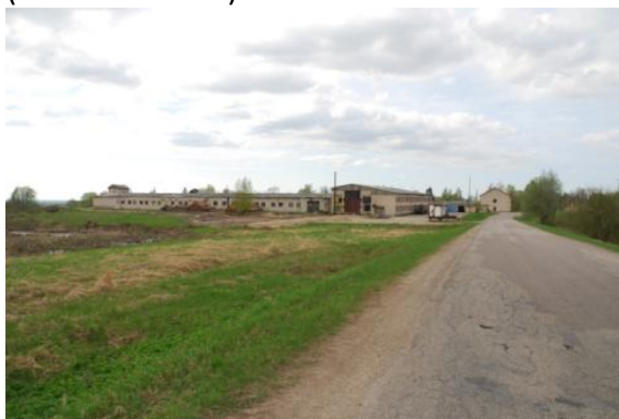
2.2.5. attēls. Tehnisko kompleksu apbūves ainava pie Mundigciema
