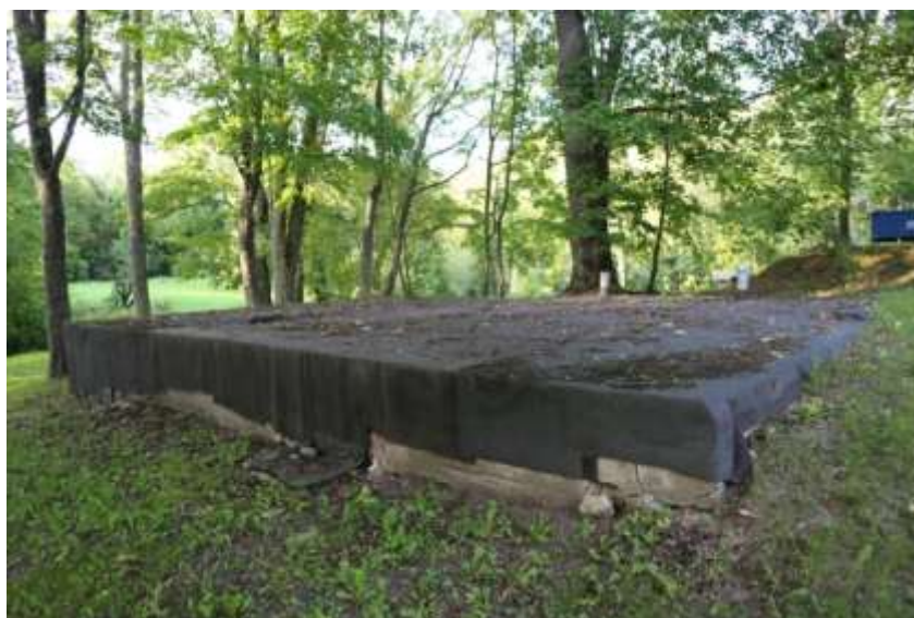
5.3.25. attēls. Ēkas pamati uz kuriem plānots izveidot āra klasi. Foto: M. Nitcis
