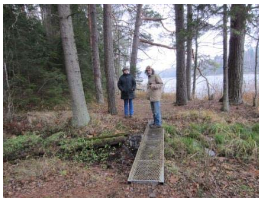
30.attēls Metāla konstrukcija – funkcionāli ļoti laba laipa pār avotu
