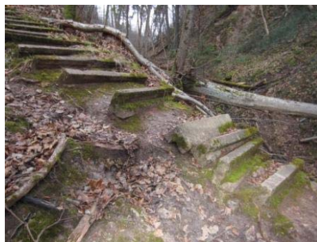
16.attēls Betona `šķilu` kāpnes
