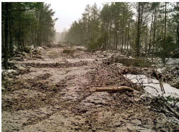
6. attēls. Pilnībā aizbērta grāvis un uz tā izveidotās ūdensnovades barjeras Zaļajā purvā.
