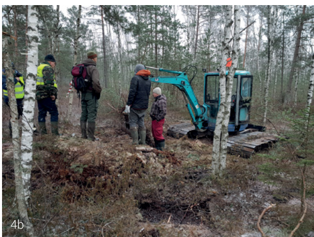
4a. un 4b. attēls. Grāvju aizbēršanai un aizsprostu veidošanai izmantotie ekskavatori Zaļajā purvā. Foto: A. Pilābers.
