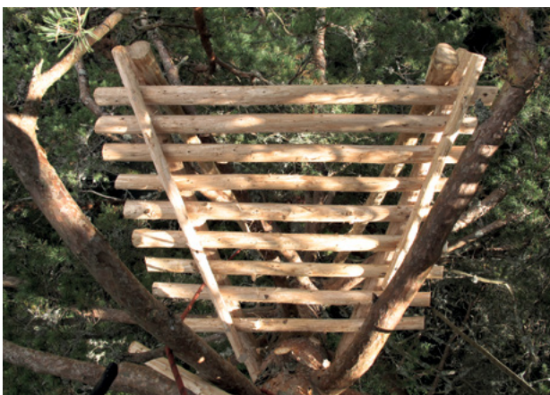
7. attēls. Pabeigta platformas konstrukcija. Lai sagatavotu labāku pamatu vainaga nostiprināšanai, var izmantot papildus šķērskokus, kas pārsisti pāri platformai virs balstu pleciem. Foto: J. Ķuze. Figure 7. Constructing of platform is completed. Fastening of nest material (branches) will be easier if additional sticks will be nailed on top of platform roughly over the nest support. Photo: J. Ķuze.
