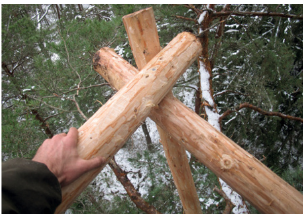
6. attēls. Pēc balstu nostiprināšanas tiek uzsākts darbs pie platformas veidošanas. Foto: J. Ķuze. Figure 6. When both nest supports are in place, constructing of platform is started. Photo: J. Ķuze.
