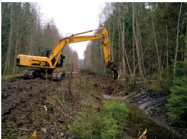
10. attēls. Grāvja aizbēršana, izmantojot ekskavatoru. Foto: A. Pilābers. Figure 10. Filling up of a forest ditch by an excavator. Photo: A. Pilābers.
