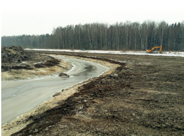
14. attēls. Izraktās grunts izlīdzināšana Skudrupītes jaunās gultnes krastos.
