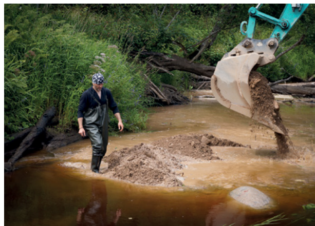
3.attēls. Berot granti, svarīgi to iespējami ātri un vienmērīgi izklāt. Foto: H. Hofmanis. Figure 3. When gravel is added to the river ground, it is important to spread it evenly and to smooth the surface. Photo: H. Hofmanis.
