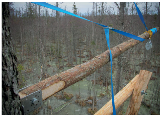
4. attēls. „Krāns” nostiprināts vietā un iekārts siksnā. Trīsis atrodas virs balstu savienojuma vietas. Foto: J. Ķuze. Figure 4. Supporting device positioned in place. Pulley is located above the joint place of nest support. Photo: J. Ķuze.
