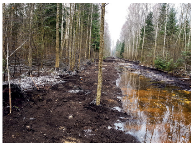
9. attēls. Pilnībā aizbērts grāvis mežā ar izveidotām grāvjiem perpendikulārām ūdensnovades barjerām.
