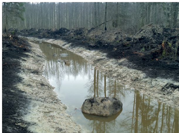
15. attēls. Upes gultnē novietoti laukakmeņi Skudrupītes posmā, kas tek caur mežu.
